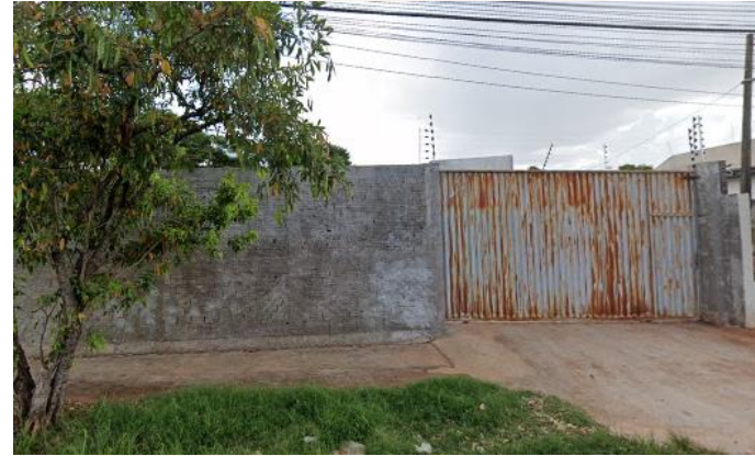
Figura 2: Fachada do imóvel utilizado como pátio dos caminhões
